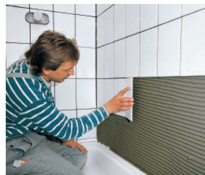
Mit PCI FT-Extra können Steingutflesien auf der alternativen Abdichtung PCI Lastogum® sicher verlegt werden.
