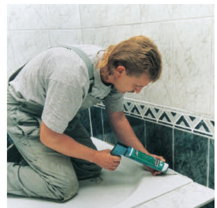
Eck-, Anschluss- und Bewegungsfugen elastisch schließen.
